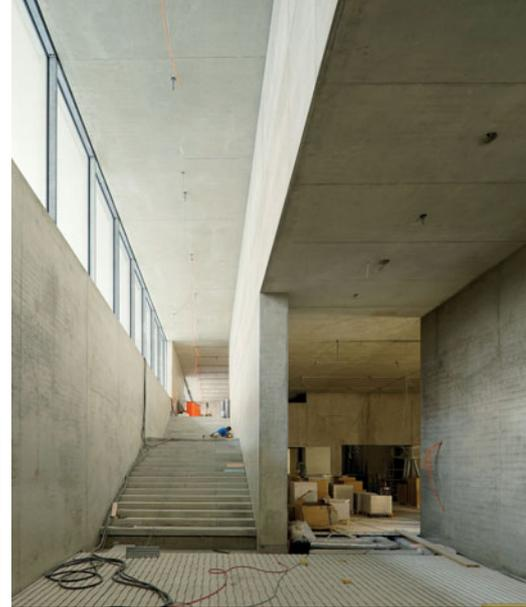
ebenfalls von der Dreßler Bau GmbH rekonstruiert wurde, entsprachen auch die Ansichtsflächen der Fertigteile für dieses Bauwerk den höchsten Sichtbetonanforderungen. Sämtliche Bauteile der Galerie zeigen sich weiß-beige mit gestrahlten Oberflächen. Auch der in der Betonrezeptur verarbeitete Marmor nimmt Bezug auf die Bestandsbauten.
